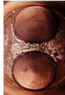
Inspección de válvulas
